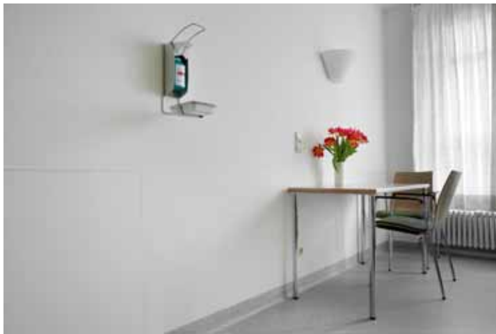
Wandschutzplatte B1 in Wandfarbe als Schutz auf der Esstischseite
