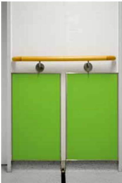
Integration einer Dehnungsfuge
